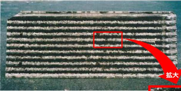
旧規格スレートは、肺がんや中皮腫の原因になるアスベストを含有しており、劣化したスレートは雨・風でアスベスト繊維が飛散する危険性があります。
