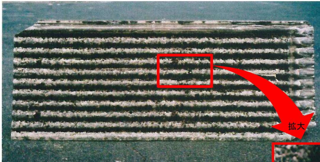
旧規格スレートは、肺がんや中皮腫の原因になるアスベストを含有しており、劣化したスレートは雨、風によりかなりのアスベスト繊維が飛散する危険性があります。
